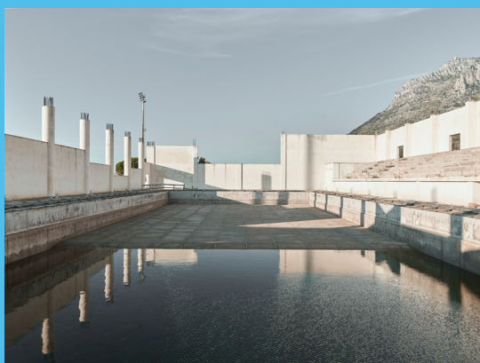
Chantier abandonné d'une piscine municipale, à Terracine dans la région de Latium en Italie, extrait de Incompiuto , Roberto Giangrande / Light Motiv
